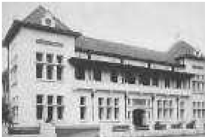
Afdeeling Handel (Bagian Perdagangan) Departemen Pertanian, Perindustrian dan Perdagangan di Jalan Ir. H. Juanda No.100 Bogor – Sekarang menjadi Gedung Ditjen Planologi Kehutanan (Sumber: Buku Gedenkschrift ter Gelegenheid van Het 25-Jarig Bestaan van Het Department van Landbouw, Nijverheid en Hendei )
